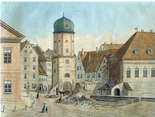
Das Rannstädter Tor während der Abbrucharbeiten (during demolition work) 1822 / F. M. (Public domain)
